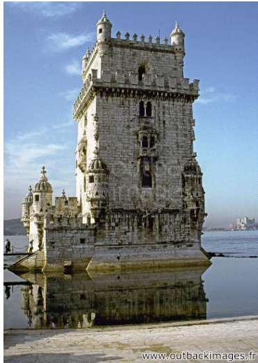
Portugal, Estremadura, Lisbonne, Tour de Belem
