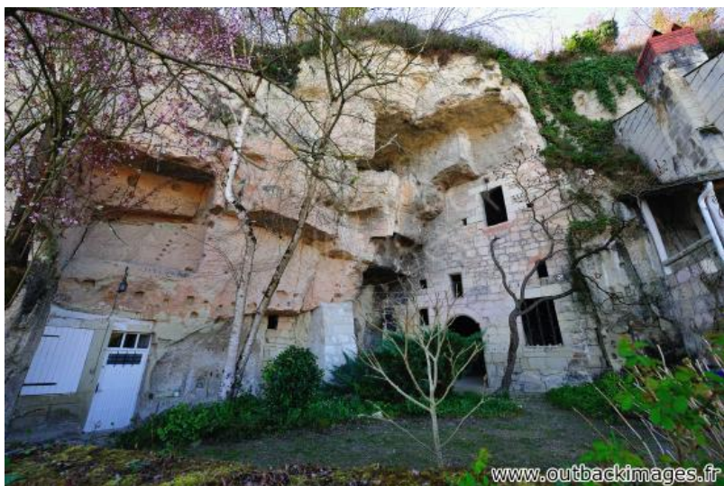
Site remarquable de Montsoreau pour ses habitations troglodytes
